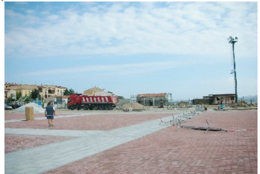
Lavori in corso al porto di Cannigione
